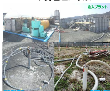
原位置処理(VOCs汚染) - 栄養塩注入状況 -
