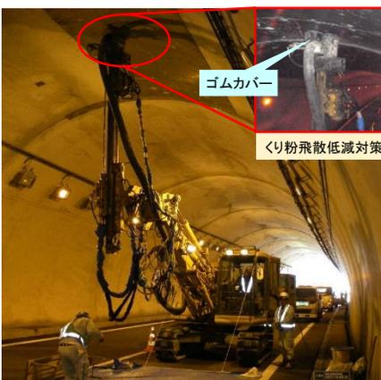
写真-2 地山削孔状況
