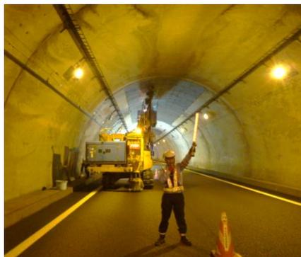
写真-1 車線規制・監視員配置状況
