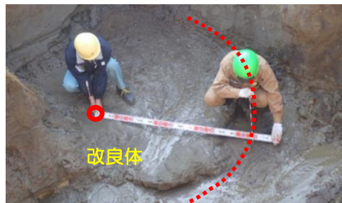
写真-2 改良体の確認状況
