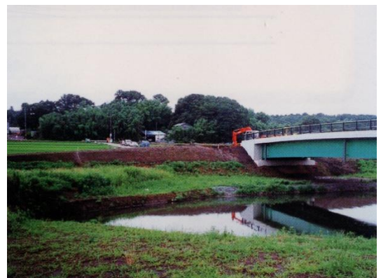
盛土材としての再利用状況
