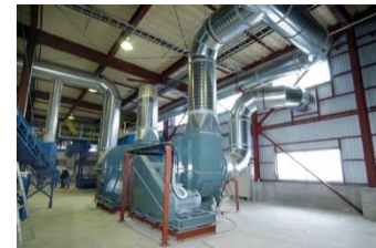
選別建屋内は、必要箇所へ給排気を行なう「第一種換気方式」を採用
