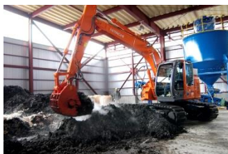
②生石灰混合処理（前処理） 高含水廃棄物は含水調整
