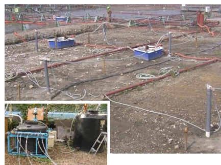
バイオレメディエーション工法(対象:VOCs、油)
