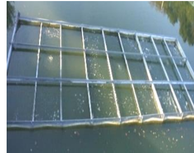
超微細気泡による生物接触曝気式水質浄化法 (対象:アオコ、有機物、窒素、リン)
