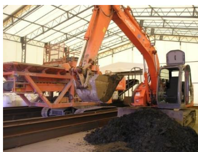
温熱処理工法(対象:VOCs)
