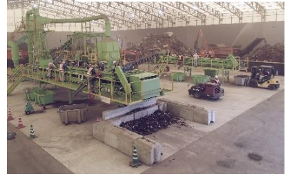
災害廃棄物処理(熊本地震)
