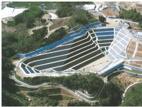
廃棄物最終処分場
