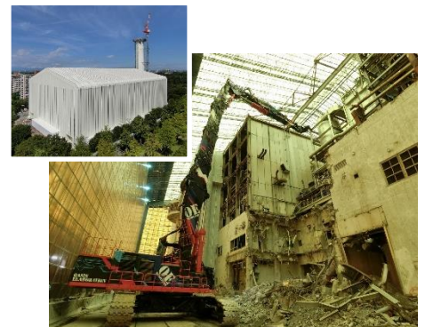
廃棄物焼却施設解体
