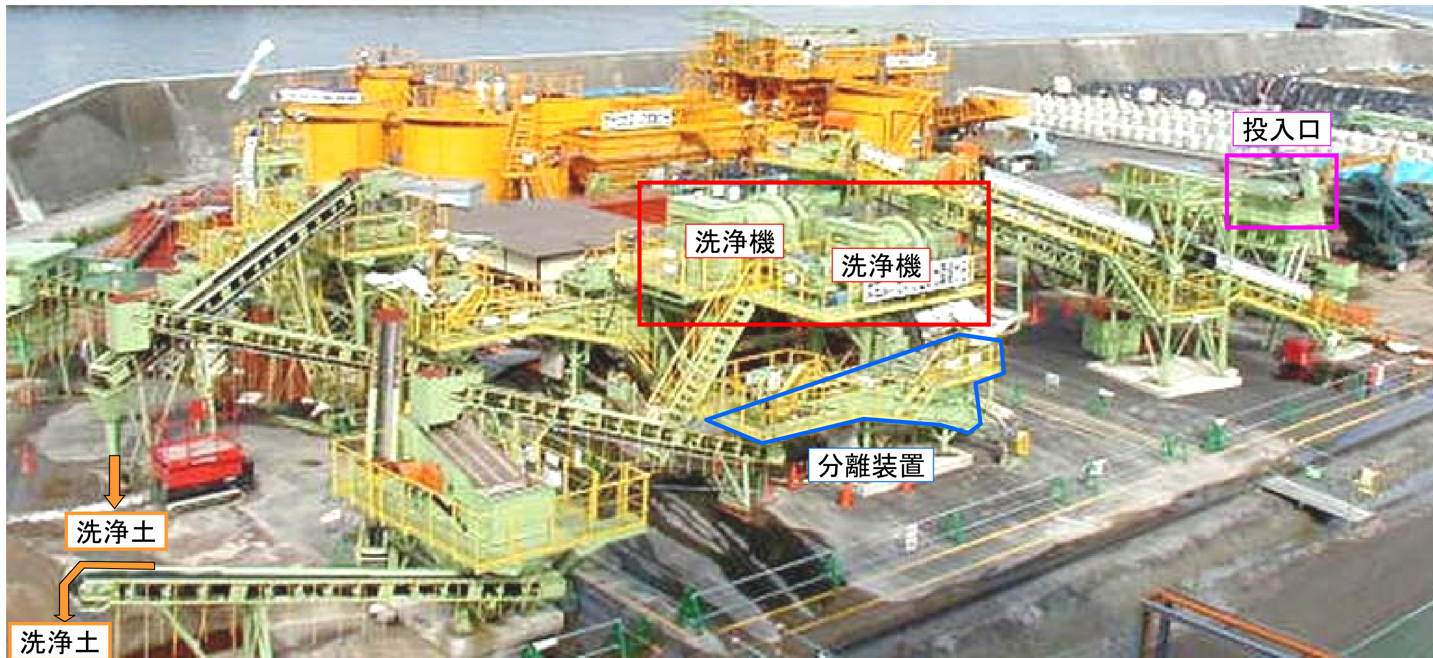
土壤洗浄設備全景（処理能力 30m 3 /Hr + 10m 3 /Hr）
