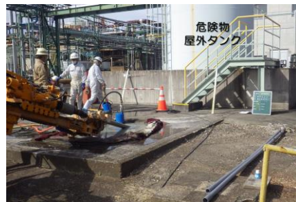
写真-2 適用事例 (既設タンクの液状化対策)
