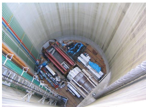
シールド立坑としての利用
