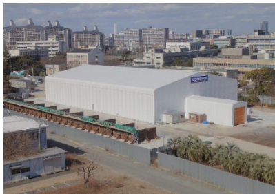
洗浄プラント外観
