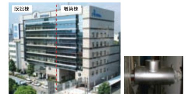
既設棟と増築棟をオイルダンパーで連結。隣棟間隔を狭めているため、外観上は1棟の建物に見えます。
