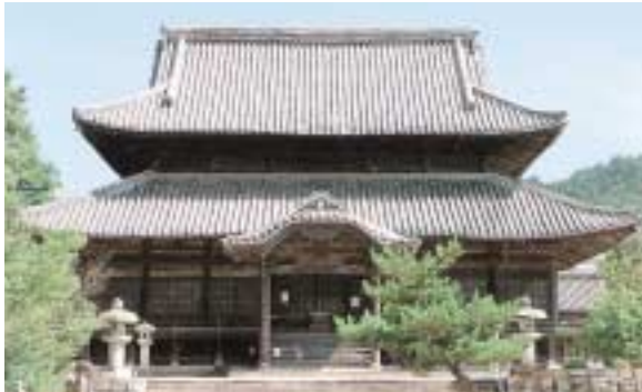
伝統木造建造物を伝統技術と新しい技術を用いて耐震補強 (重要文化財 周防国分寺金堂)
