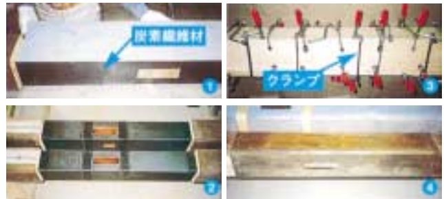
炭素繊維補強 (施工手順①～④)
