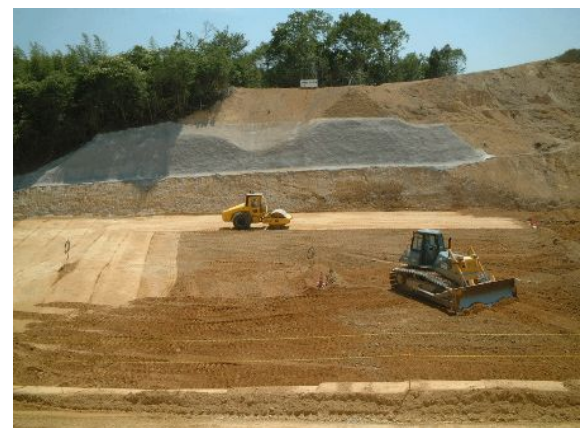
堤体盛土状況
