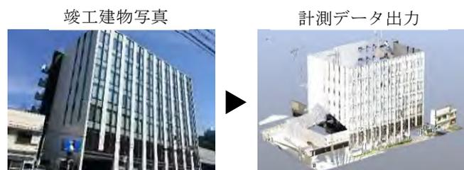
図 5 3D スキャナーによる竣工建物の計測例
