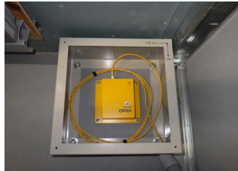
(b) 地震計設置状況
