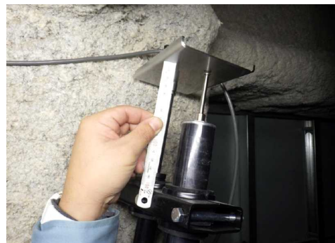
(d) 変位計設置状況(端部)
