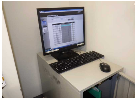
(a) 収録機器等設置状況
