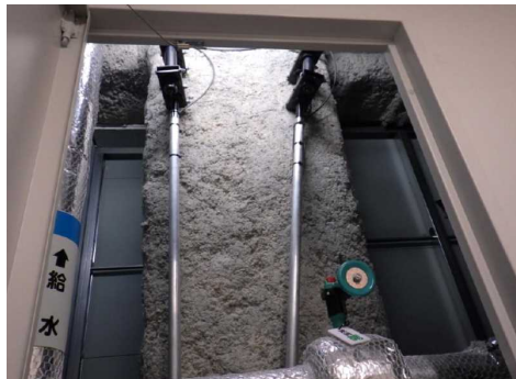
(c) 変位計設置状況
