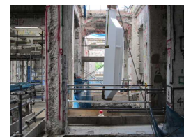
写真10 鉄骨柱取り込み
