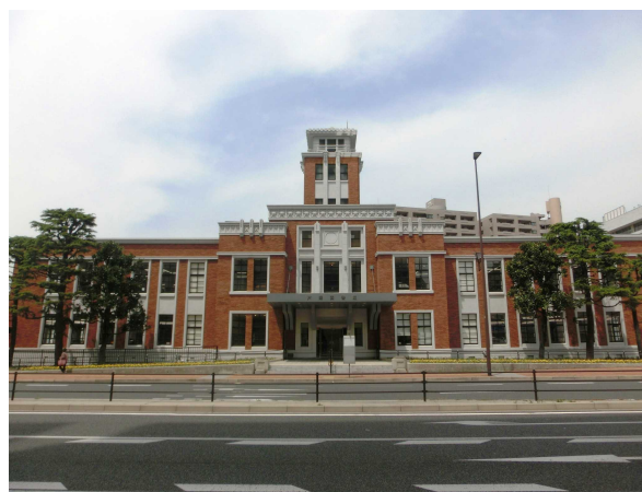
写真2 建物外観(改修後)
