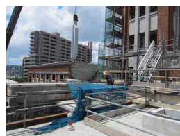
写真9 鉄骨柱荷取り
