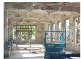
写真21 既存躯体調査②
