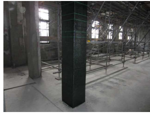
写真23 炭素繊維補強
