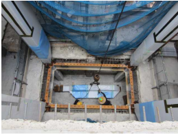
写真13 鉄骨柱仮置き
