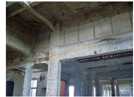
写真19 梁・床の劣化状況
