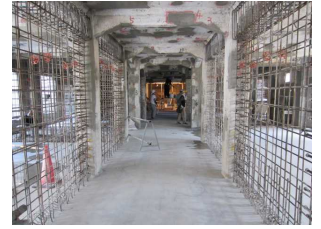
写真4 耐震壁の増設
