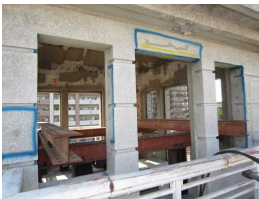
写真15 塔屋取り込み架台
