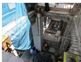
写真11 鉄骨柱取り付け
