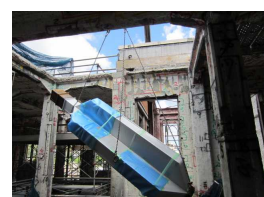
写真12 鉄骨柱取り込み
