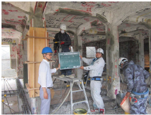
写真22 グラウト注入
