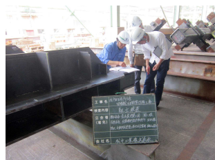
写真5 アーチフレーム 柱組立検査
