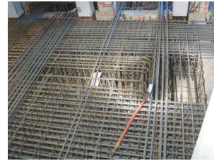
写真3 基礎梁の補強
