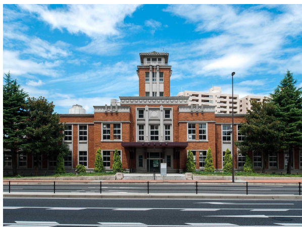
写真1 建物外観(改修前) ※撮影：是本信高
