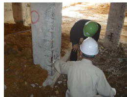
写真18 柱の劣化状況
