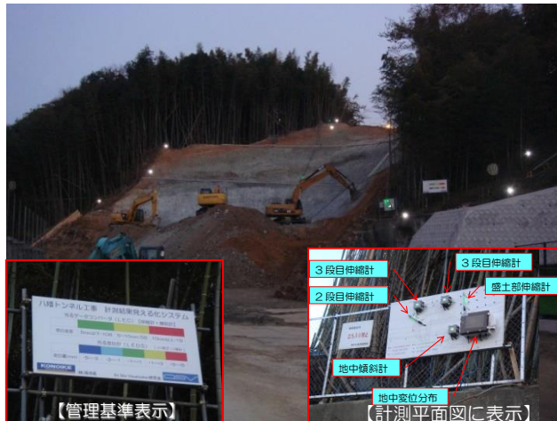
写真-1 切土掘削管理における見える化実施状況
