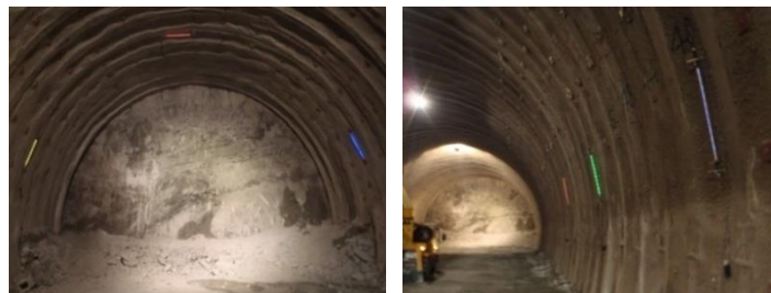
写真-2 トンネル掘削管理における見える化実施状況
