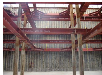
開削後の地中壁体状況（漏水なし）
