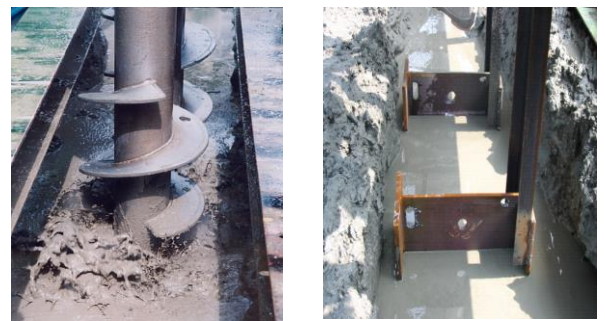
高流動化技術による施工状況
