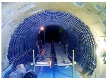
鋼製リングをセグメントに溶接
