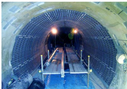
嵌合部材組み付け完了
