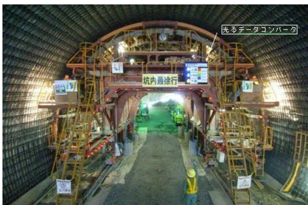
写真-4 打設応力を発色表示で見える化して管理 (北関東自動車道出流原工事 出流原トンネル)
