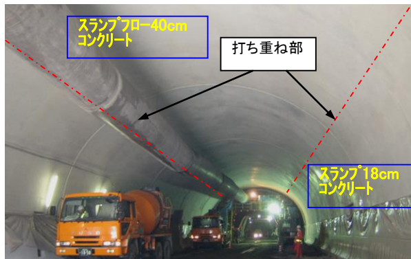
写真-1 高品質・高充填覆工コンクリート現場適用
