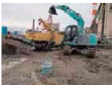
固化材の投入状況
