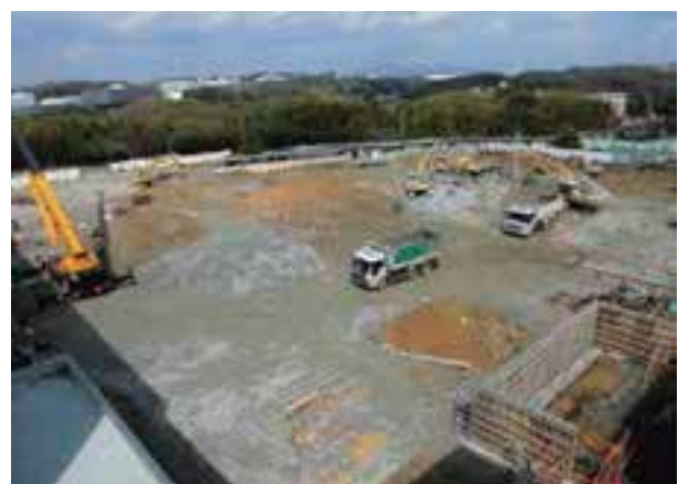
ガラパゴスによる再生砕石生成及び敷き均し
