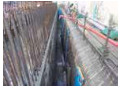
流動化処理土埋戻し
